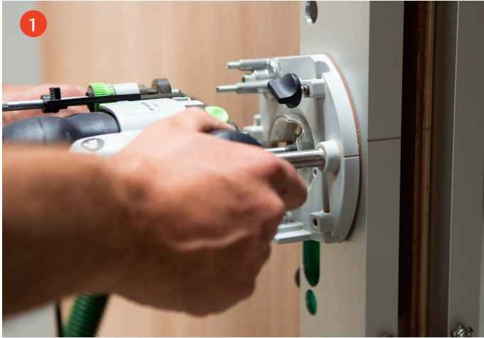
1 Frezen pc/krukgat en bevestigingsgaten Frees het pc-gat, het krukgat en de bevestigingsgaten uit.
