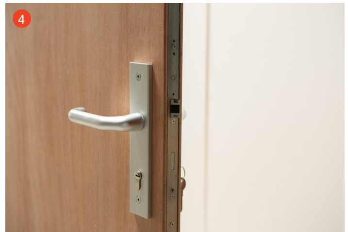
4 Monteer het slot en het deurbeslag Controleer de werking van het slot
